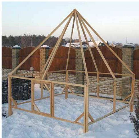
Рисунок IV.38 – Каркас теплицы [138]
