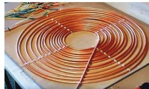
**Рисунок I.55 – Постепенно закрепляем весь моток. Торчащие части хомутов отрезаем**
