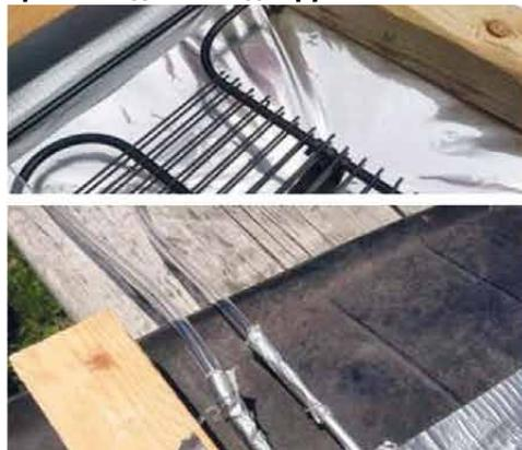
**Рисунок I.45** – Для вывода трубок в каркасе были сделаны пазы. Для подвода воды к змеевику нужна ПВХ трубка. Герметизация соединений обеспечена скотчем
