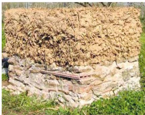
**Рисунок I.19 – После чего укладываем саман на подготовленный фундамент, чтобы высота печи составляла 80 см**
