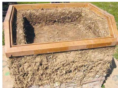
**Рисунок I.22 – Саман выкладываем ровень с деревянным каркасом, не забывая сделать выемку для возможности размещения кастрюли**
