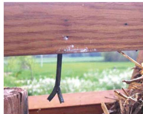
**Рисунок I.21 – Чтобы деревянный каркас надежно был зафиксирован в самане, в нижней части каркаса необходимо прикрепить металлические штыри**
