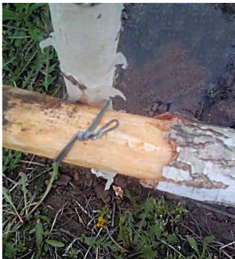
Рисунок IV.42 – Крепим поперечины при помощи обычной проволоки
