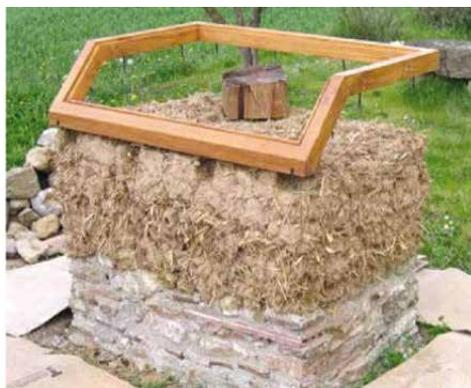
**Рисунок I.20 – Устанавливаем деревянный каркас высотой 20 см**
