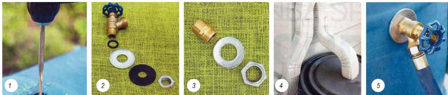
Рисунок III.5 – Порядок шагов по оборудованию бочки для сбора дождевой воды [123], [159]
