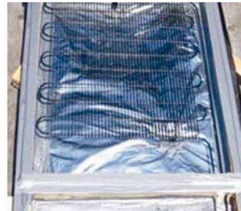
**Рисунок I.47** – Накрываем стеклом и проклеиваем по периметру скотчем. В нижней части вкручиваем шурупы для упора, чтобы стекло не сползло
