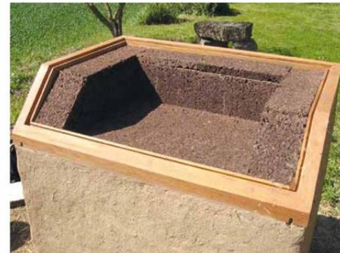
**Рисунок I.24 – В верхней части печи необходимо уложить теплоизоляционный материал (пробка, минеральная вата и т.д.)**
