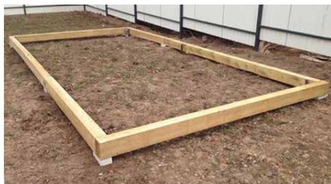
Рисунок IV.30 – Укладка бруса на грунт
