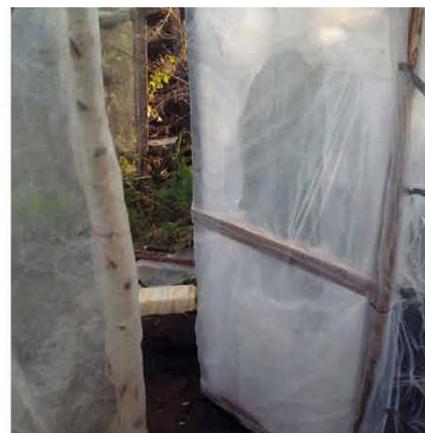
Рисунок IV.46 – Сделаем дверь из реек и пленки, вместо петель используем обычную проволоку
