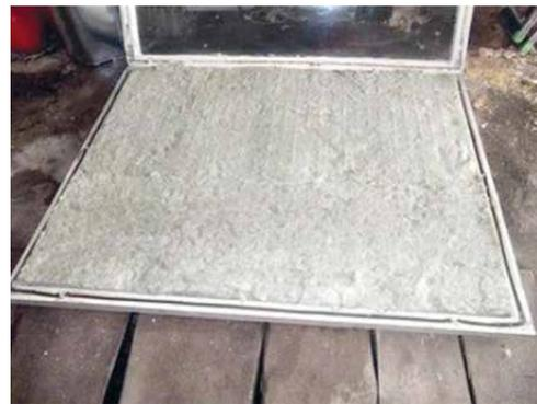
Рисунок I.49 – Необходимо удалить одно стекло и пустой проем забить фанерой (OSB). Открываем окно книжкой и укладываем на дно слой теплоизоляционного материала толщиной 3 см
