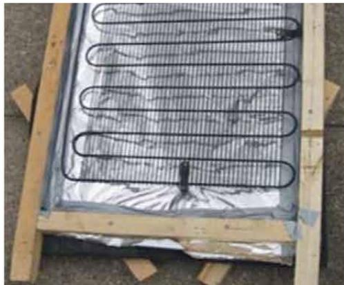
**Рисунок I.46** – Для крепления змеевика использовались хомуты, снятые с холодильника. Крепление хомутов обеспечено скотчем. Для надежности закрепить винтами
