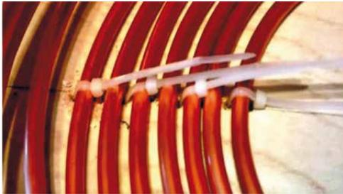
Рисунок 1.56 – Сверлим отверстия по диаметру хомутов и крепим ими трубку
