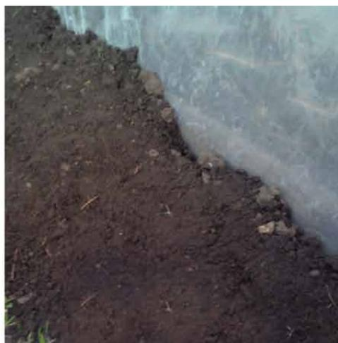
Рисунок IV.45 – Сверху насыпаем земляной вал или же заваленку
