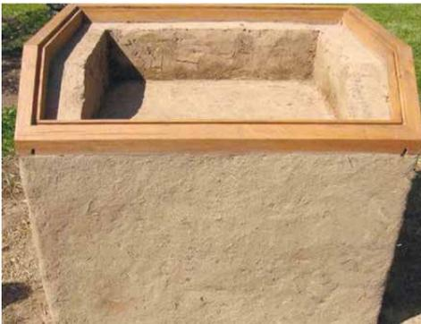
**Рисунок I.23 – Из оставшейся глины штукатурим поверхность (сглаживаем неровности) солнечной печи**
